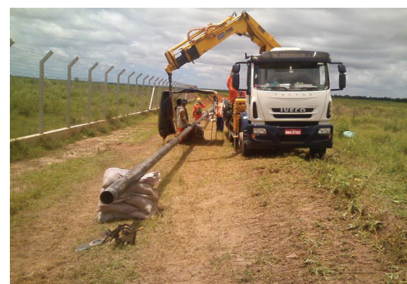
Atualmente, a obra do gasoduto está em fase de acabamento
